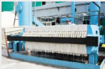
因合三车间津液废水在排放过程中含有大量的生产物料,不仅造成了物料的浪费,还给后续的污水处理带来了一定难度。
